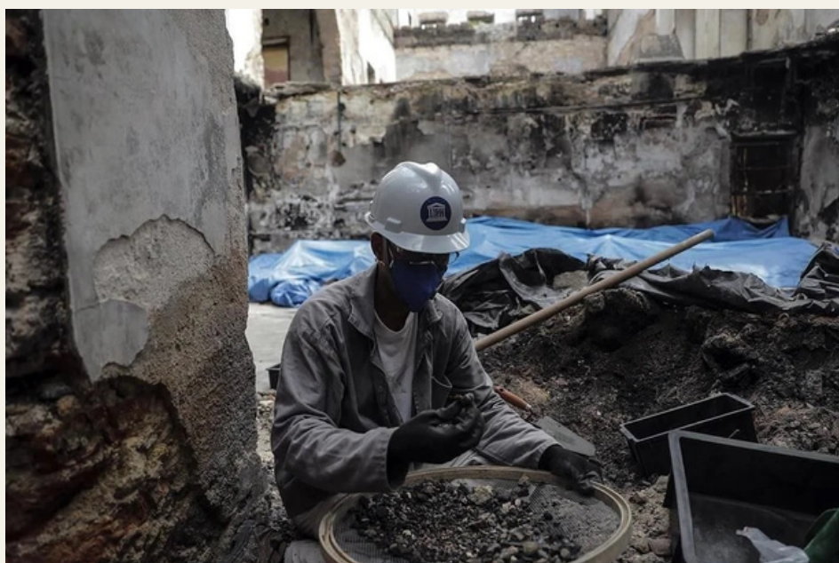
Trabajos de rescate entre los escombros del Museu Nacional, tras el incendio de 2018.
